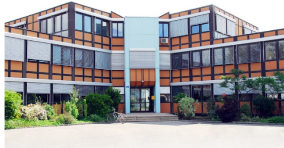
Unsere Firmenzentrale in Korneuburg
